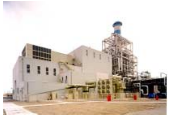
図-4 高砂製作所コンバインドサイクル実証設備外観
