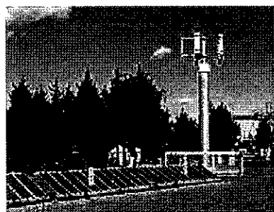
図 5 風力・太陽光発電による水素貯蔵 system (那須電機鉄工(株)敷地内)
