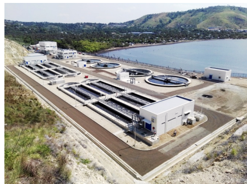
写真2 下水処理場全景写真
