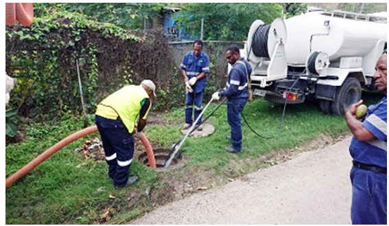
写真3 管渠清掃の状況
