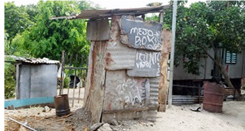
写真1 ピットトイレの状況 (ピットトイレ：尿尿がいっぱいになると場所を変えて設置する簡易トイレ)
