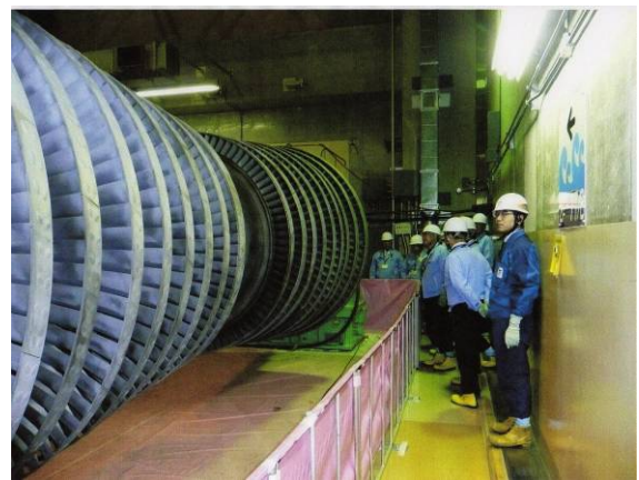
写真-2.2.2 補修後の高圧タービンロータ (東電提供)
