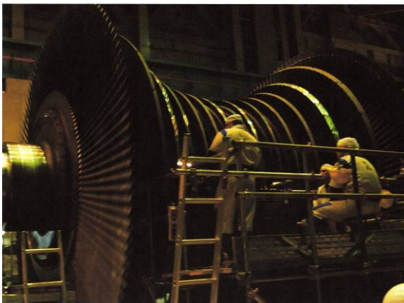
写真-2.2.1 低圧タービンロータの現地バランス (東電提供)
