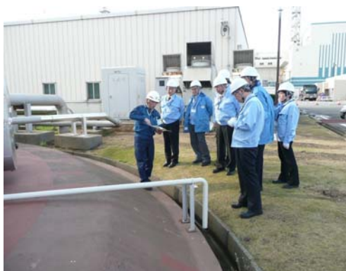
NO.4ろ過水タンク調査
