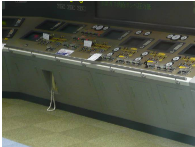
写真-4.3.1 手すりを追設した中央制御盤
