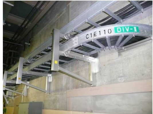
写真-4.2.4 ケーブルトレイのサポート強化(東電提供)
