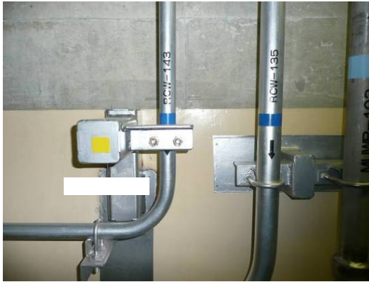
写真-4.2.3 小口径配管等のサポート強化(東電提供)
