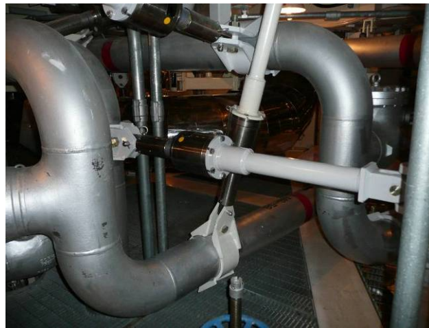
写真-4.2.5 ドライウエル内配管のメカニカルスナバ追加(7号機)(東電提供)
