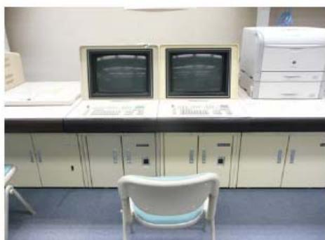
写真-3.5.2 SPDS(Safety Parameter Display System) (東京電力(株)提供)
