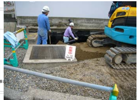
写真-3.4.8 A系タンク近傍の埋め戻し土の沈下 (東京電力(株)提供)
