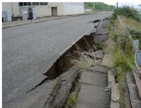
写真-3.4.9 構内道路亀裂の復旧状況
