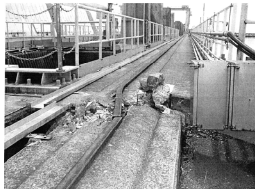
写真-3.4.7 クレーンレールの破損 (出典:原子力安全・保安部会)
