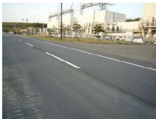
写真-3.4.10 建屋近傍埋め戻し土地盤沈下の復旧状況
