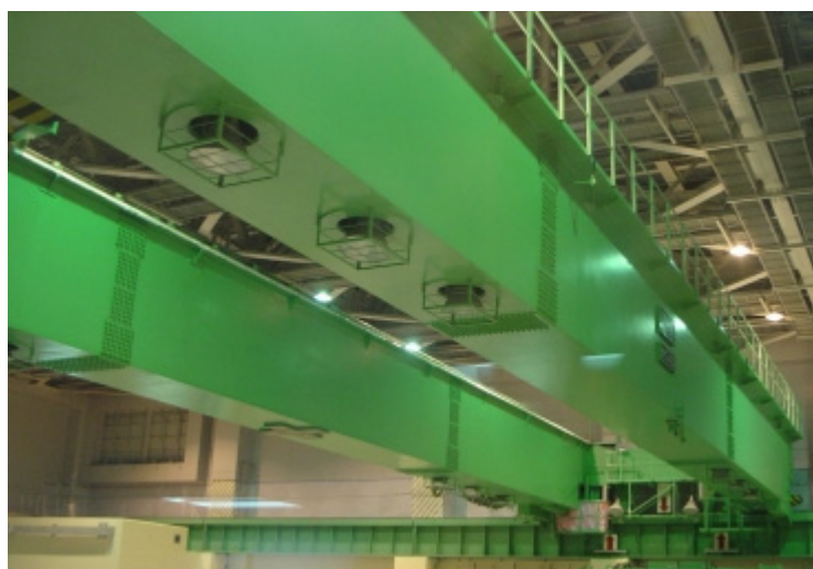
写真-3.1.2 天井クレーン本体(異常なし)(東京電力(株)提供)
