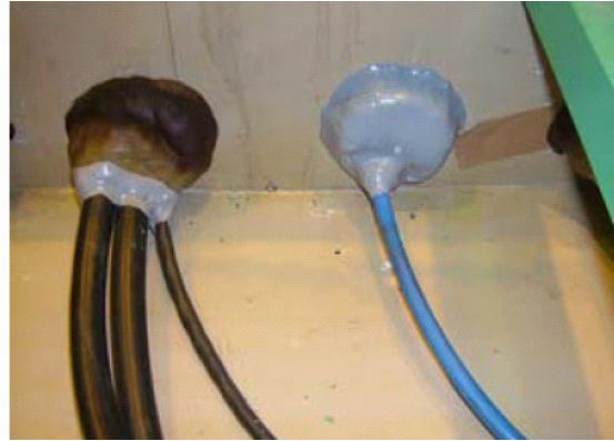
現在(止水処理後の貫通部)
