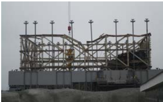
福島第一原発1号機のガレキ撤去
