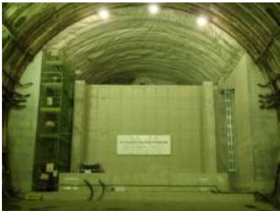
中深度処分調査坑の外観
