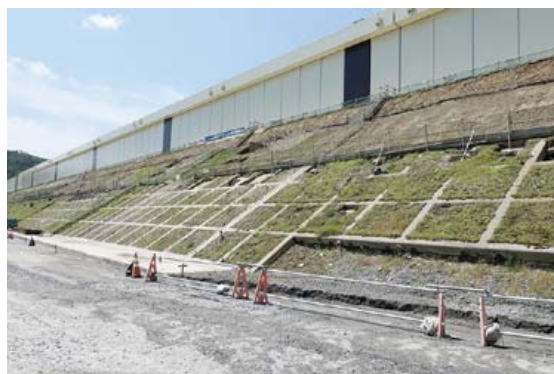
図3 防潮堤（工事中：2017.6.22撮影）（提供：東北電力） 提供する使命感と地元重視の姿勢である。
