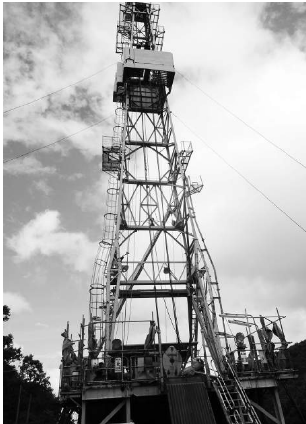
写真1 地熱井掘削リグ (掘削深度5 000 m級、槽高さ50 m)
