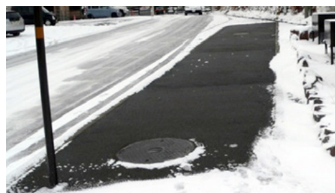
写真 1 温泉廃湯（地熱）を利用した融雪状況
