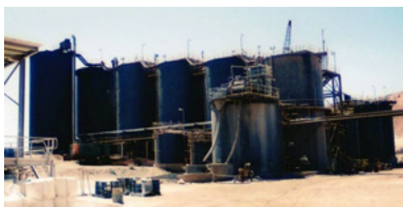
写真2 CIPプラントの一例
