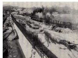
中心コンクリートコアの打込作業と射水作業
