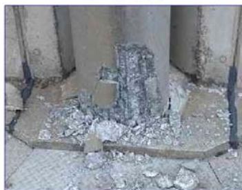
電化柱損傷状況
