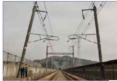
電化柱損傷状況
