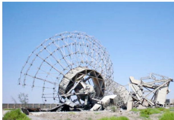
写真1 戦闘で破壊されたバグダッド郊外の通信施設
