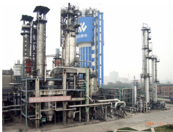
写真 2 2 460 t/d ACES21™ プラント
