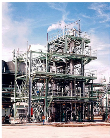
写真 1 10 t/d パイロットプラント
