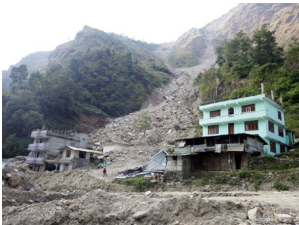
写真1 地震に伴い発生した崩壊による被害
