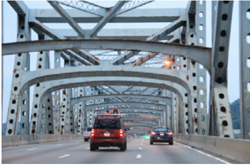
写真1 オハイオ州の橋梁を点検中の様子
