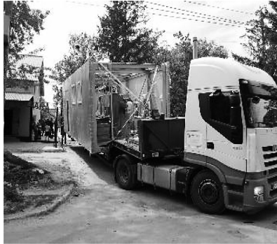
写真 5(b) 輸送中のモジュール
