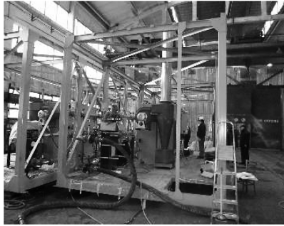
写真 5(a) 組立中のモジュール
