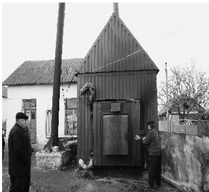
写真2(a) わらボイラー外観
