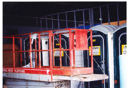
写真1 ニューヨーク市の建設現場の女性トイレ
