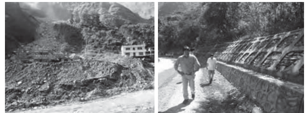
写真2 アラニコ道路の被害 写真3 シンズリ道路の被害
