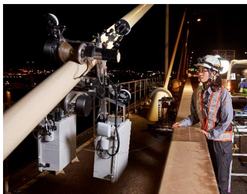
点検ロボットによる斜張橋の点検
