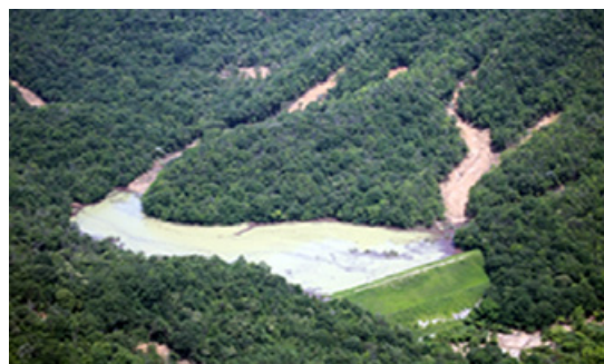
写真1 土石流が流入したため池
