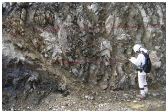
写真1 ダム基礎岩盤の掘削現場
