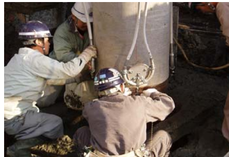
PC杭への熱交換パイプ設置状況
