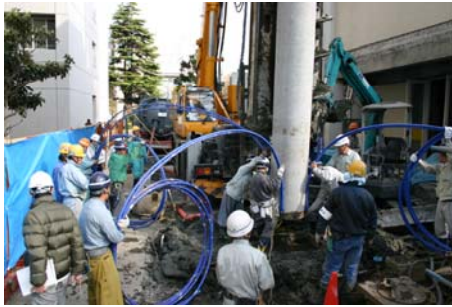
杭利用垂直システム（高密度PE管）
