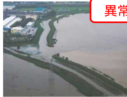
図：洪水被害の事例 (写真提供：国土交通省中部地方整備局)
