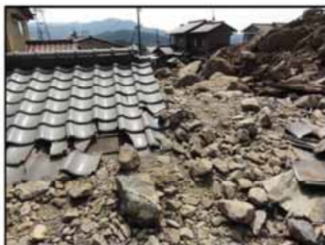
写真11 回り込んだ土石により埋没した住宅
