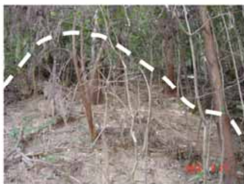
写真-8 崩壊に至らなかった斜面
