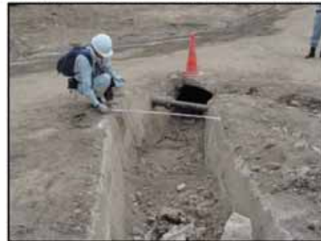
写真6 沢から住宅地を通過する水路
