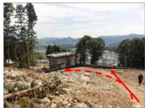
写真13 大型土嚢による仮設堰堤
