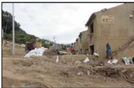
写真5 土砂に埋まった沢左岸側の県営住宅。 2階部分まで土砂流の跡がある。
