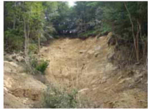
写真-17 主溪流源頭部 崩壊C
