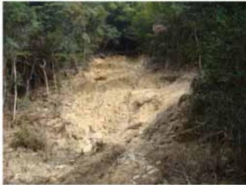
写真-15 主溪流源頭部 崩壊A
