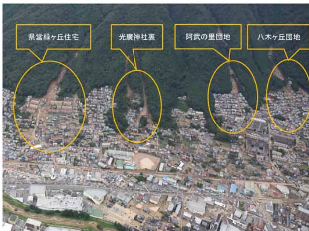
図 2-4 人的被害の多い八木 3 丁目の被災箇所
