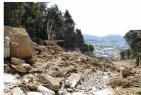
写真 3 八木 3 丁目県営緑丘住宅付近
