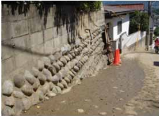
写真-6 道路の勾配は 14.6 度
