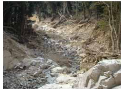
写真-12 氾濫堆積域の始まり
