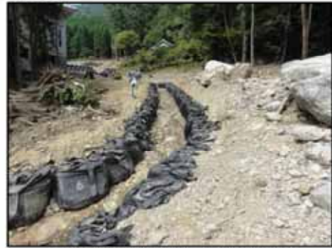
写真12 大型土嚢による仮設水路
