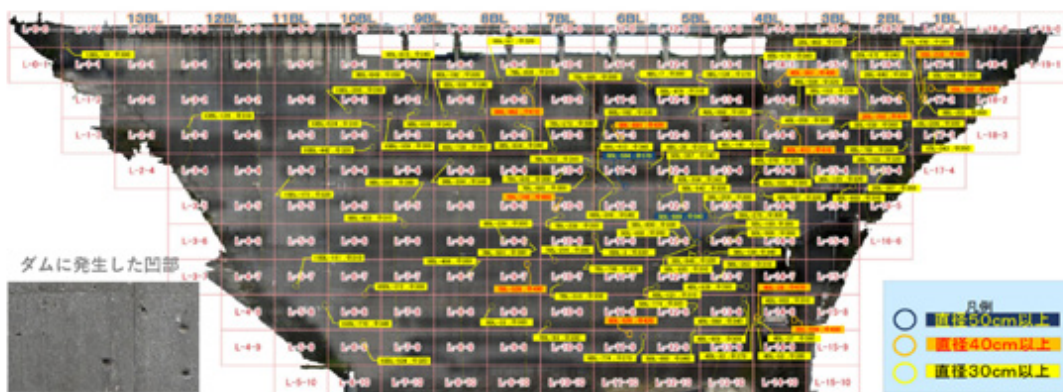
図2 ダム堤体凹部のAIによる検出結果 5)
