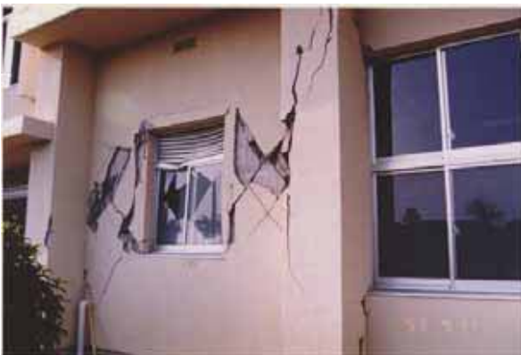
Fig. 5 鹿児島県北西部地震、第 2 鹿児島県北西部地震（応急補強有）
