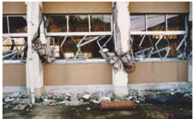
Fig. 4 鹿児島県北西部地震、第 2 鹿児島県北西部地震（応急補強無）
