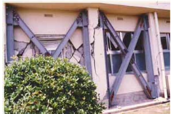
Fig. 5 鹿児島県北西部地震、第 2 鹿児島県北西部地震（応急補強有）
