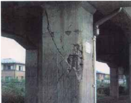
Fig. 3 鉄道高架橋 RC 柱の復旧状況/エポキシ樹脂注入工法（三陸南地震）
