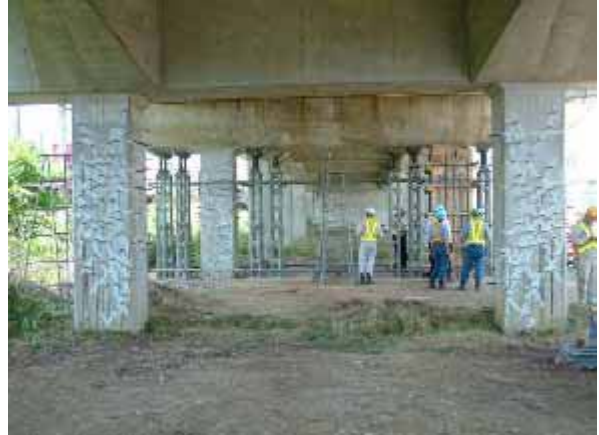
Fig. 3 鉄道高架橋 RC 柱の復旧状況/エポキシ樹脂注入工法（三陸南地震）
