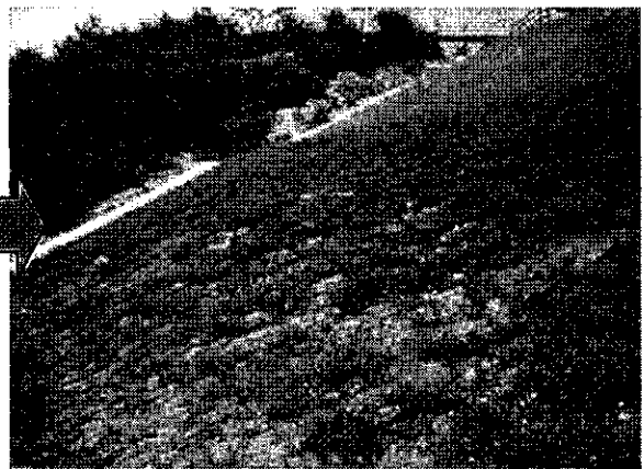
写真-12 水生植物を利用した保護工
