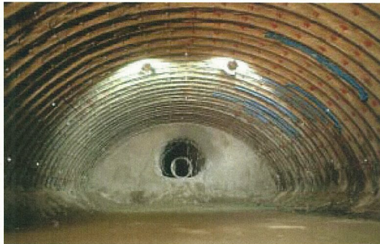
[写真一 第二名神(高速国道)新栗東トンネルの支保工(施工状況)]
