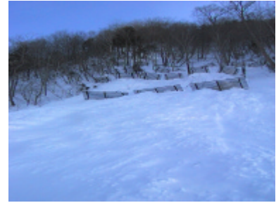
図 12 吊柵をすり抜けた雪崩(北海道)
