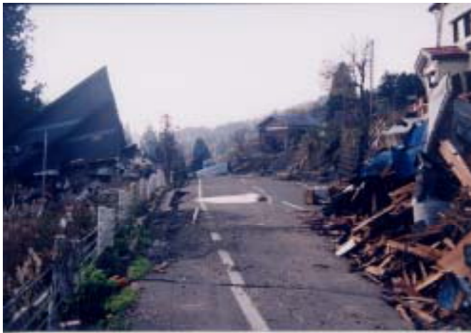
写真1 地震動や宅地の崩壊により被災した家屋（旧山古志村）。
