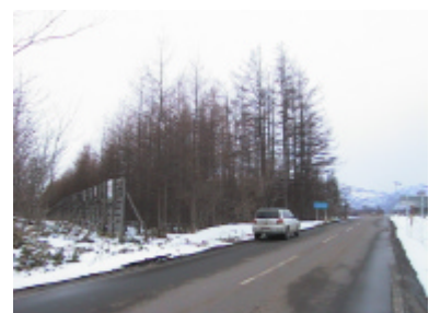
図 17 防雪林と防雪柵(北海道)
