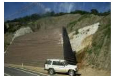
図 20 補強土壁工(新潟県山古志)
