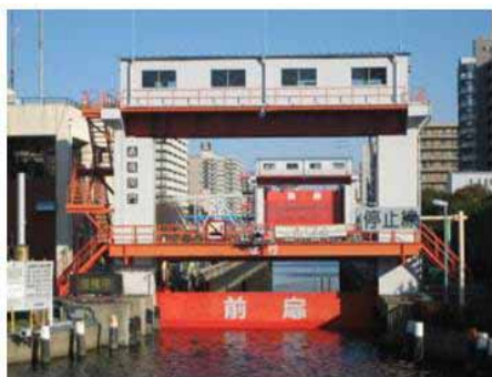
図8. 扇橋閘門・新扇橋より撮影
