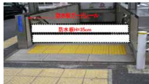
図 3. 地下鉄出入口の止水板
