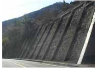
図３ コンクリート張工法
