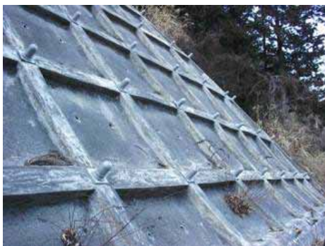
図５ 法枠工法（吹付工併用）
