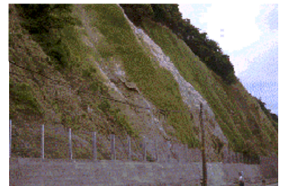
図４ 待受式擁壁工法
