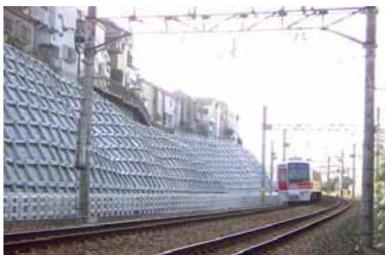
図9 法枠工に鉄筋挿入工を加えて補強した事例（相模鉄道 横浜市 旭区）
