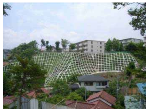
図６ 法枠工法（緑化工併用）
