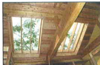
放射冷却窓全開時
