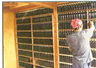
保冷用PETボトル (南面に設置)
