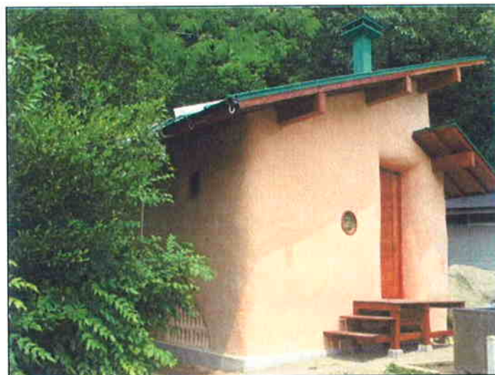
完成した非電化野菜貯蔵庫全景
