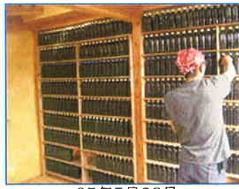
05年5月28日 棚作り、保冷用PETボトル設置
