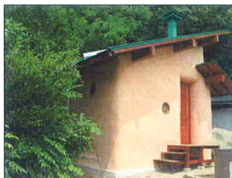
05年6月18日に完成した非電化野菜貯蔵庫(撮影:藤村)
