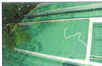
放射冷却窓全閉時 (断熱扉は手動開閉式)
