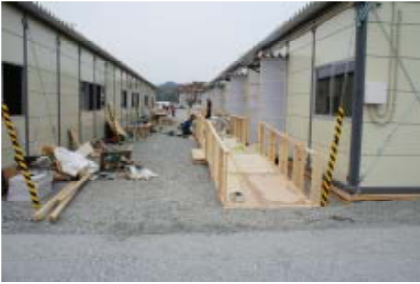
写真 6 建設中の仮設住宅（気仙沼中学校）
