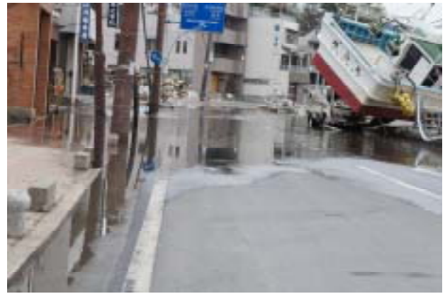
写真 9 冠水による道路の通行止めの状況
