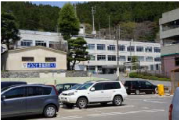
写真 2 津波の先端がきた気仙沼市役所
