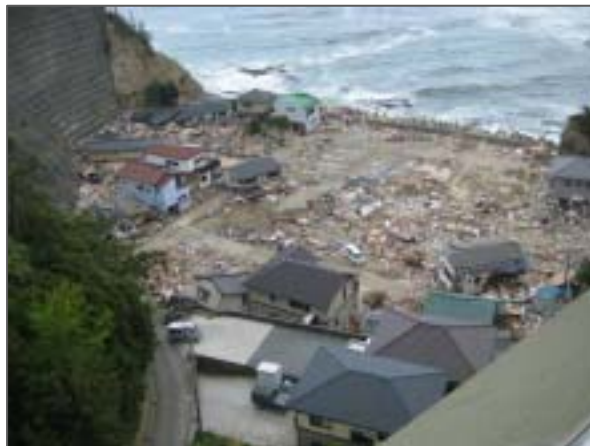
Hサッパシヅクからの合磯海水浴場(砂浜があり被害が少ない)と合磯岬内湾(周辺は岩盤で家屋流出)
