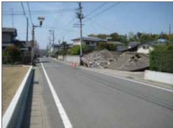
広野町中心街の倒壊家屋
