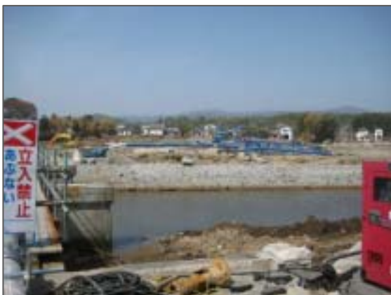
北追川の水道橋欠損(対岸の青色のパイプ)
