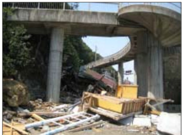
波立地区の横断歩道橋の海岸部基礎
