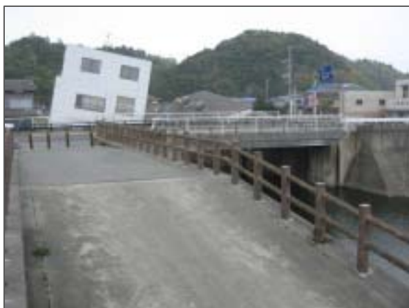
永崎地区天神前川河口両岸の家屋倒壊
