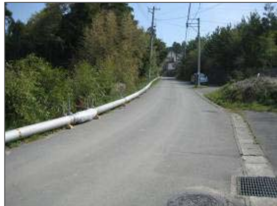
仮設水道管を県道沿い敷設(火力発電所用)
