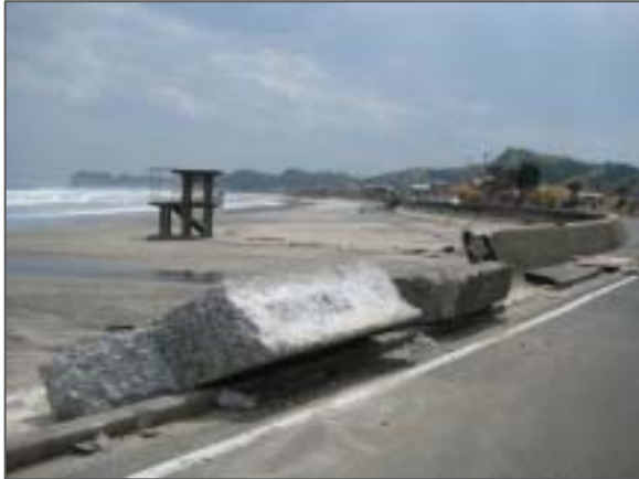
平沼ノ内は津波で護岸が欠損し、家屋被災等の規模を大きくしている。
