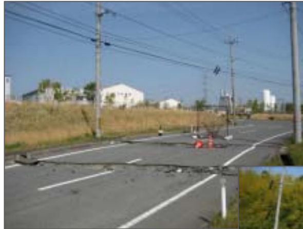
主要アクセス路は、舗装クラックで、通行止めとなっている
