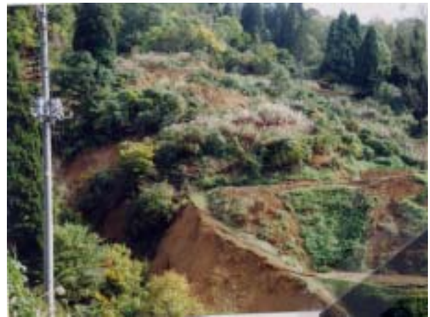
山間部の地滑り崩壊箇所
