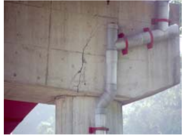
山辺橋 ラーメン橋脚の塑性ヒンジ
