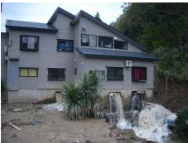
小千谷市浦柄地区 地滑りによる河川災害
