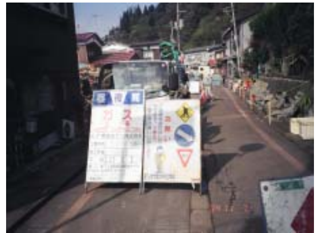
川口町 ライフラインの緊急復旧工事
