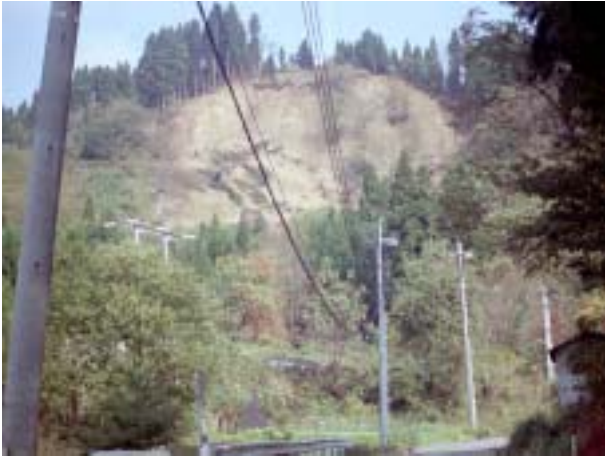
川口駅背面の地滑り箇所
