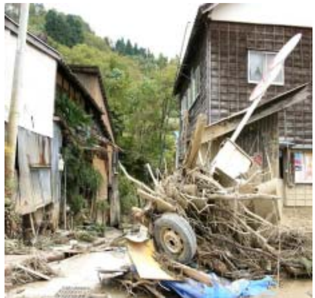
写真6 小千谷市浦柄地区の土石流災害
