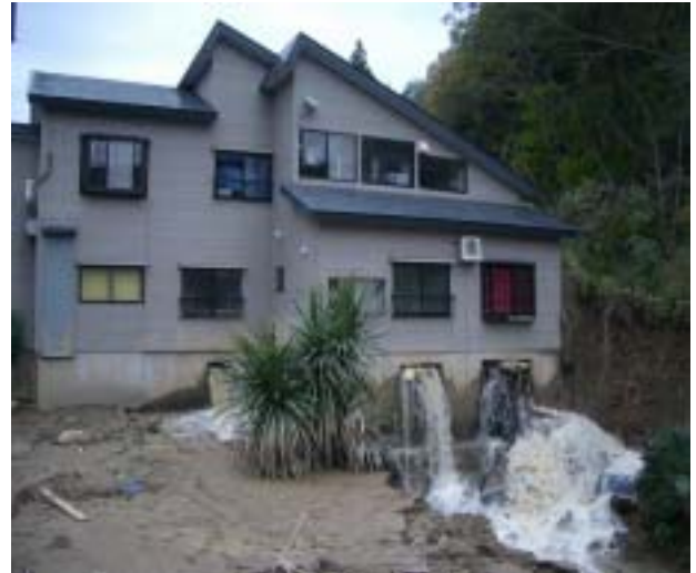
写真5 小千谷市浦柄地滑りによる河川災害
