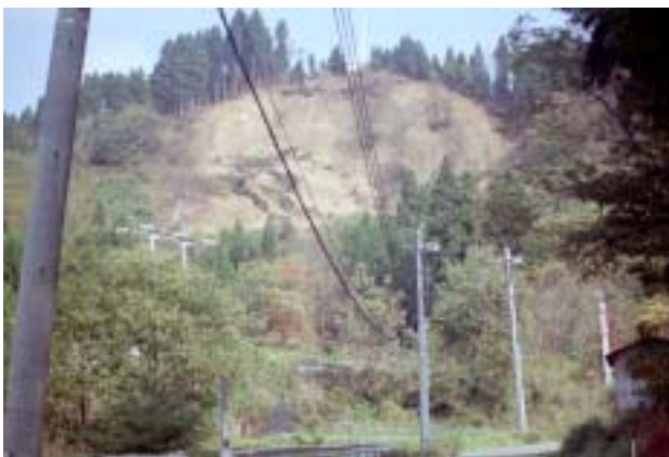
写真4 川口駅裏山の崩壊危険箇所
