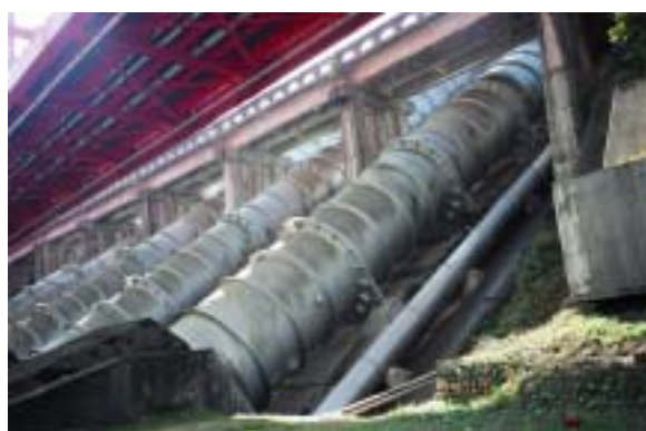
写真17 小千谷発電所のペンストック
