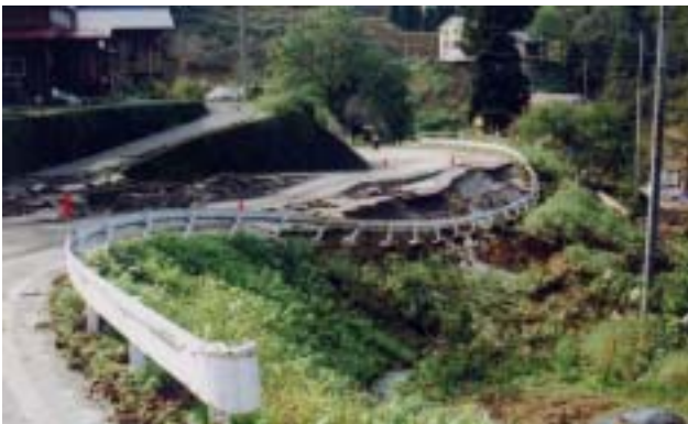
写真 10 県道小栗山川口線うどぎ地区
