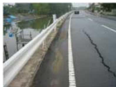
東名運河沿い道路沈下による亀裂
