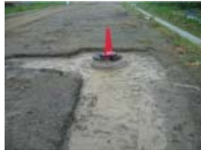
管路、マンホール周辺の液状化による沈下
