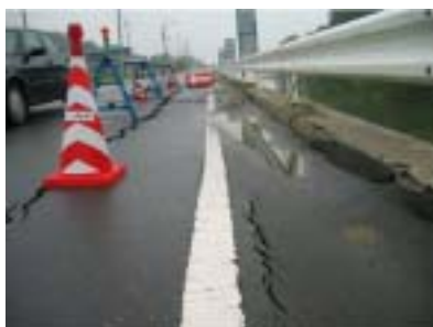
東名運河沿い道路沈下による亀裂
