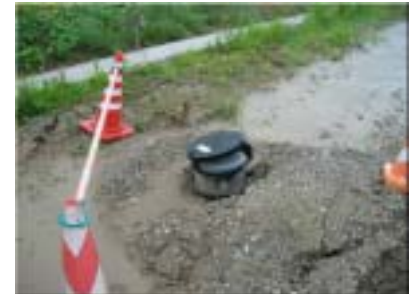
管路、マンホール周辺の液状化による沈下
