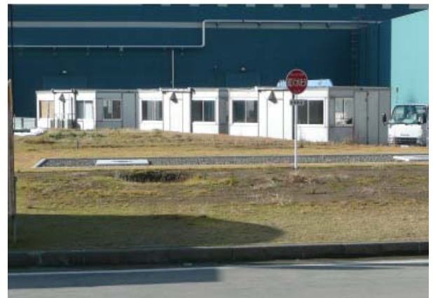
写真-2.4.8 防火水槽の埋設配置状況(手前の砂利部) (東電提供)
