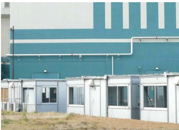
写真-2.4.7 消火系埋設配管の架空化の復旧状況 (東電提供)
