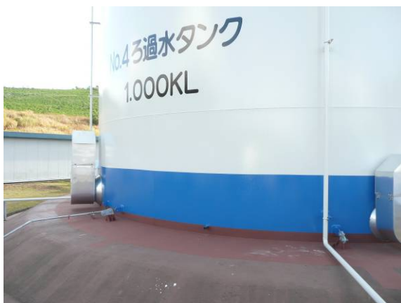
写真-2.4.10. 修復されたNo. 4ろ過水タンク（東電提供）
