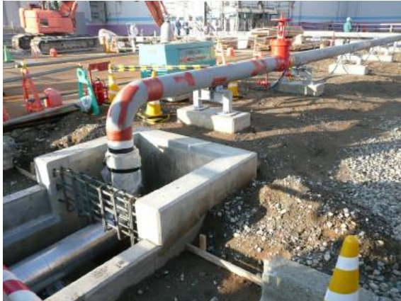
写真-2.4.6 消火系埋設配管の地上化の復旧状況 (東電提供)
