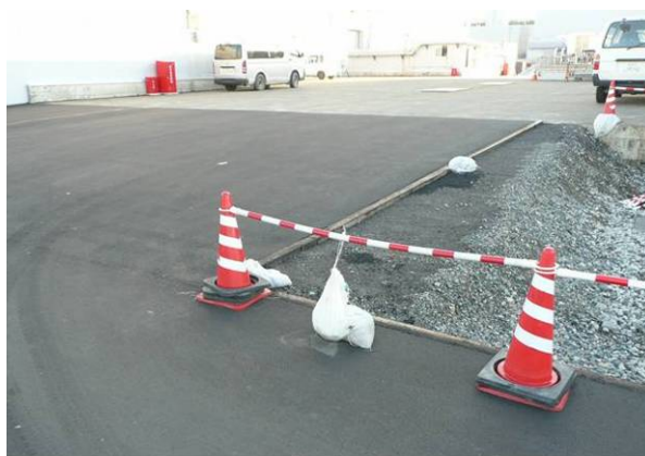
写真-2.4.4 施設の復旧工事の進捗にあわせて進められる構内道路の修復状況 (東電提供)
