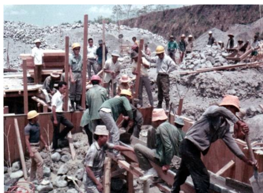
砂防堰堤工事作業中（中央黄ヘルメットが筆者）
