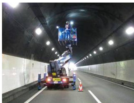
図-1 トンネル点検状況
