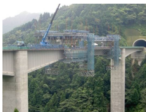
図-2 PC橋幅工事状況
