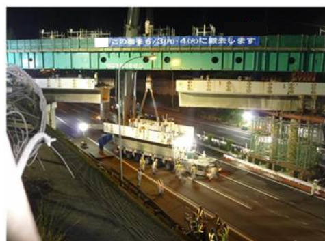
図-3 跨高速道路橋撤去状況
