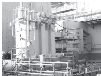
写真1 新製3号機所内変圧器(3B)の据付工事状況
