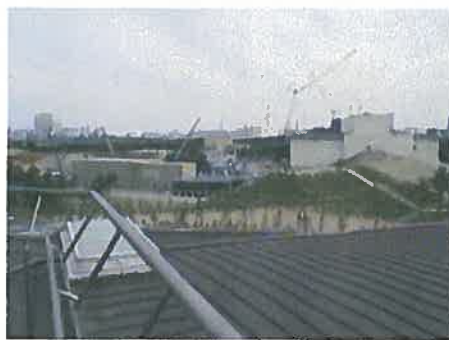
02 50GeVトンネル建設
