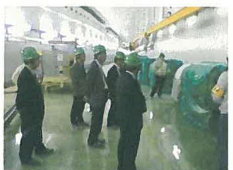
15 50GeVトンネル4
