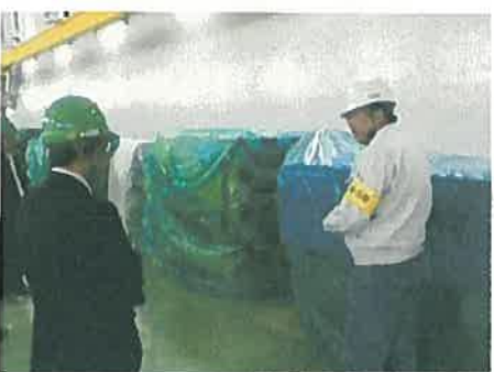
14 50GeVトンネル3
