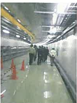
13 50GeVトンネル2
