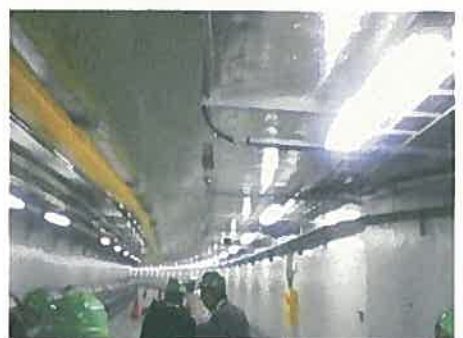
12 50GeVトンネル
