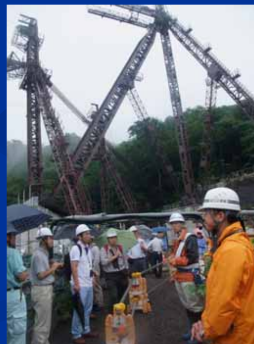
ハツ場ダム建設工事現場（8月）
