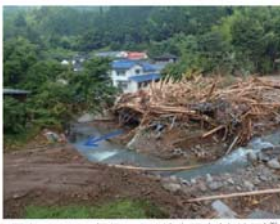
写真-2.6.5 橋梁による流木阻害(中鈴橋)
