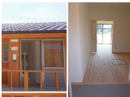
相良村松葉仮設団地
